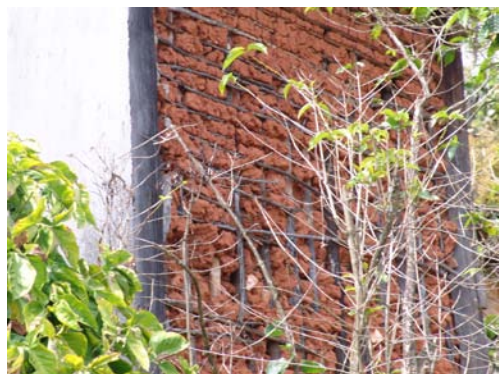
Fotos 9 e 10 – Exemplos de edificações com o sistema construtivo – pau-a-pique – visível. Autor: Neno Viana. São Bartolomeu, outubro de 2005.
