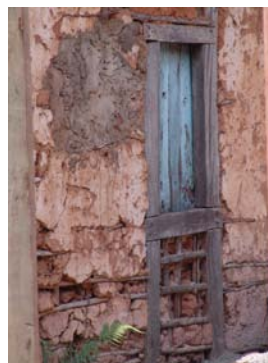
Fotos 9 e 10 – Exemplos de edificações com o sistema construtivo – pau-a-pique – visível. Autor: Neno Viana. São Bartolomeu, outubro de 2005.
