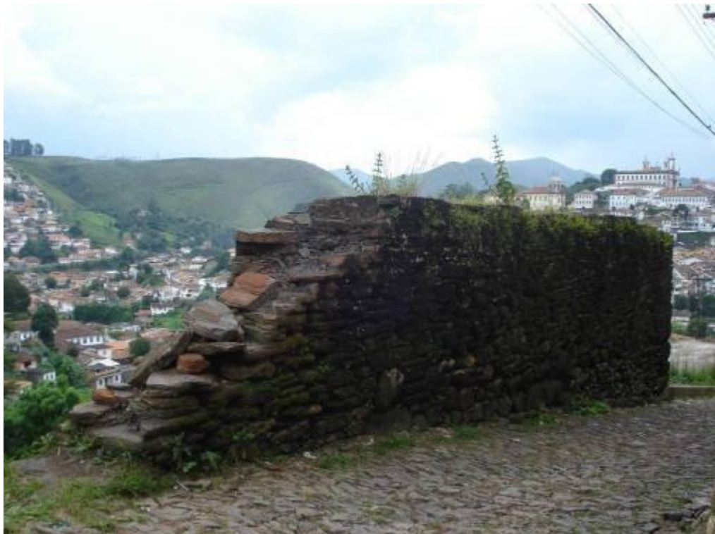
Limites das ruínas do Palácio Velho – Rua Chico Rei. Destaque para o remanescente muro de pedras secas e parte do mesmo, destruída por acidente veicular. 2009 – Bruno Tropia Caldas
