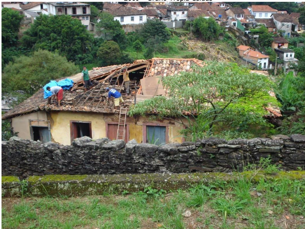
Vista do imóvel – reforma do telhado em janeiro de 2009 2009 – Guilherme Ismar Nunes Ataídes
