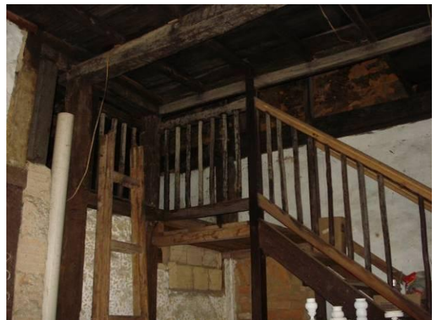
Escada de acesso ao sótão.
