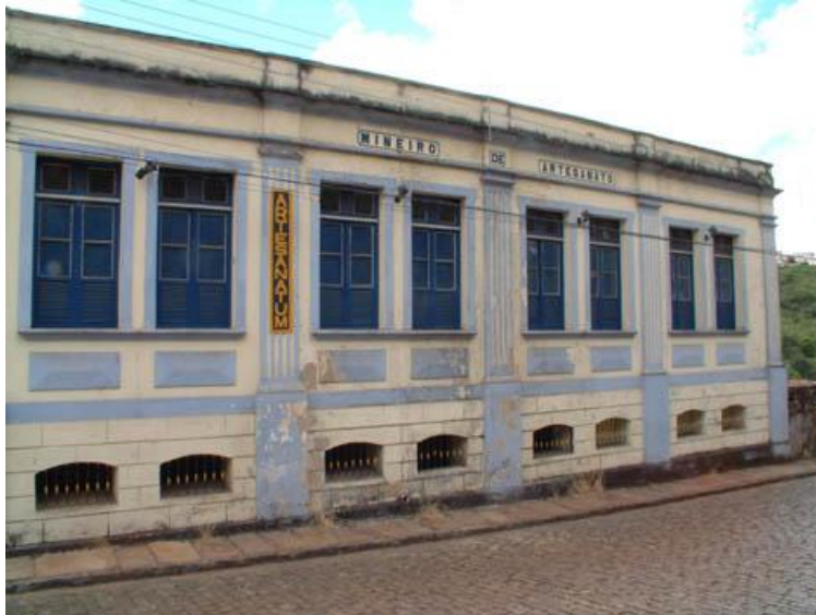
Vista exterior – Foto de 2002 (Fonte: IPHAN, 2002).
