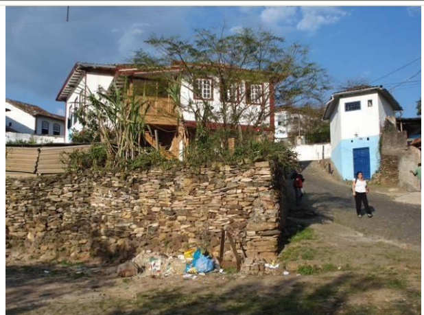
Vista do arrimo em pedra com a Rua Alagoas ao lado.
