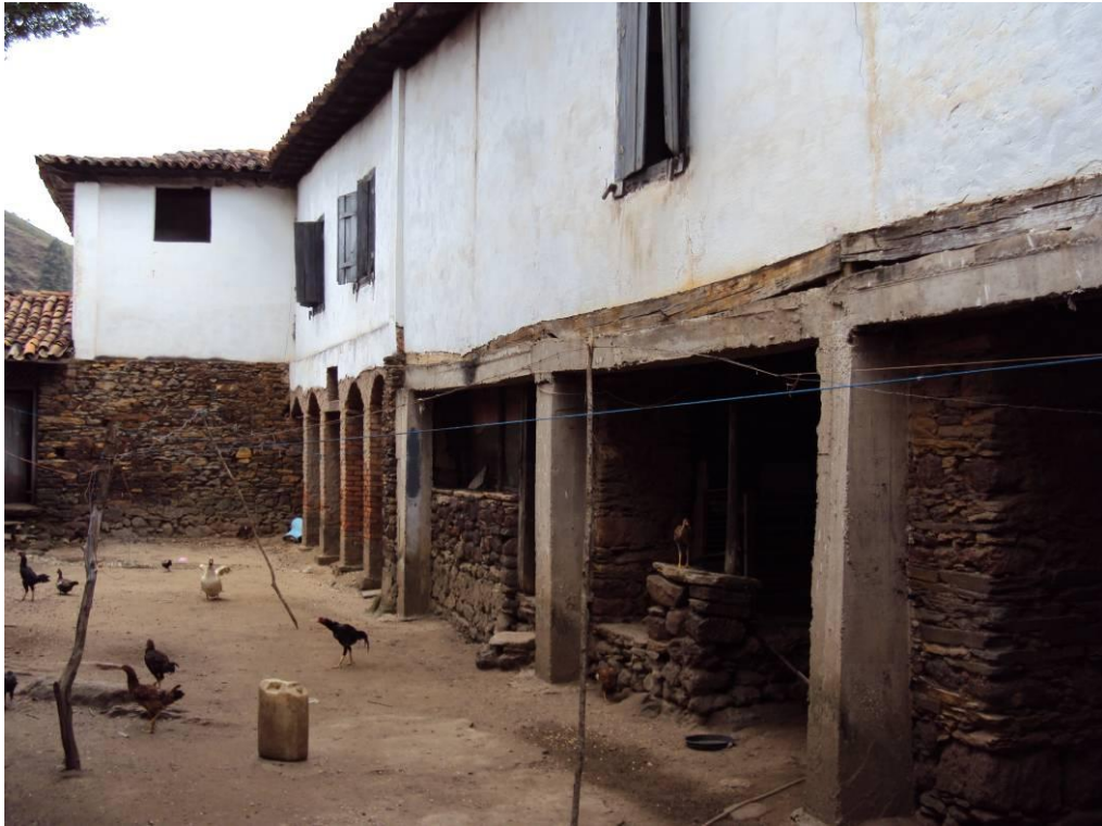
Vista Fachada Lateral Direita; pátio interno 2009 – Ricardo dos Santos Teixeira
