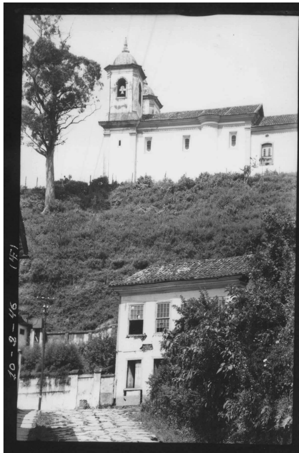
Fachada lateral Fonte: Acervo digital IFAC
