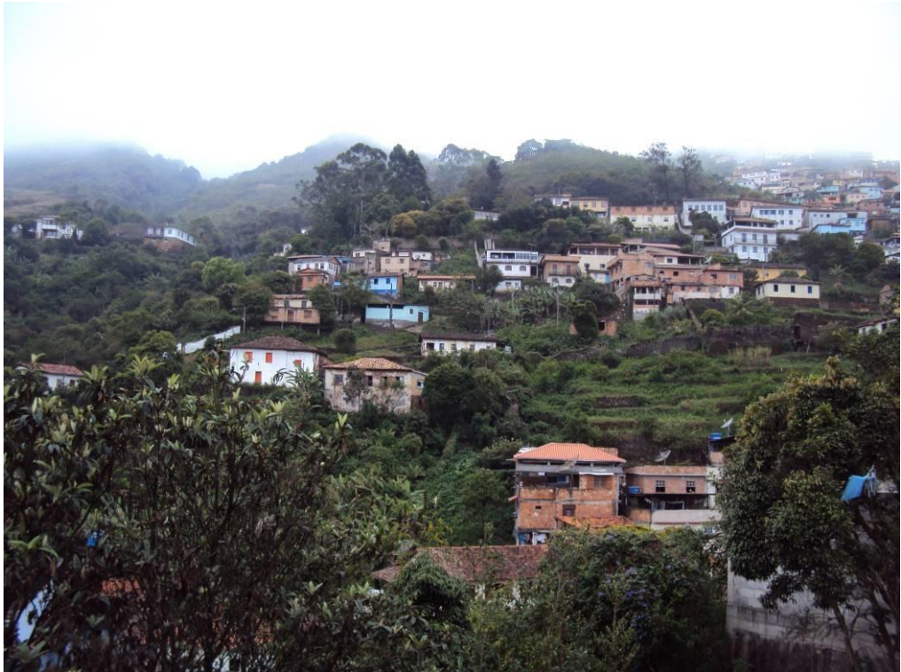
Vistas a partir de janela da fachada posterior: à esquerda, vista das ruínas do Palácio Velho 2009 – Ricardo dos Santos Teixeira
