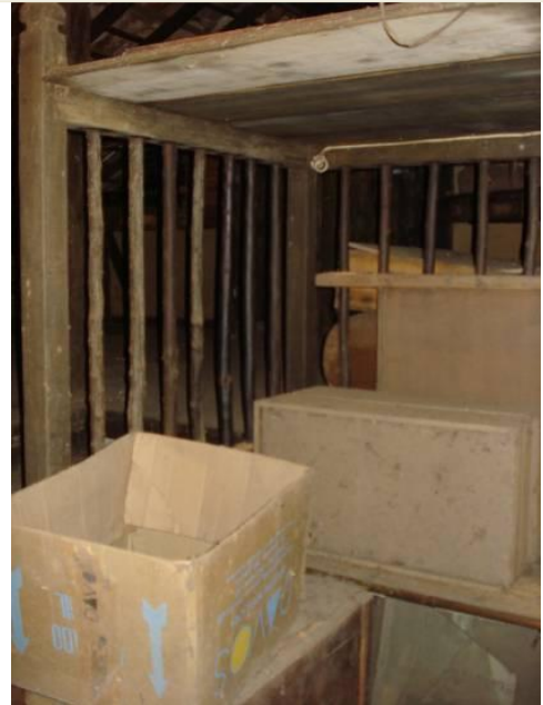
Sótão. Estruturas em madeira.
