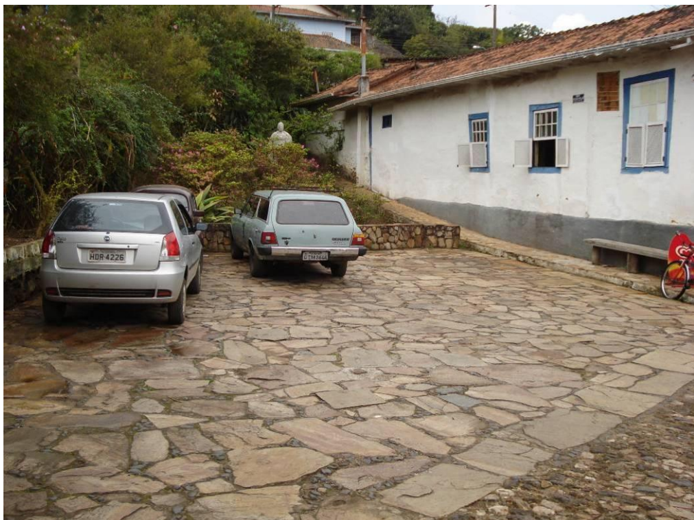
Vista do estacionamento ao lado do imóvel 2009 – Ricardo dos Santos Teixeira
