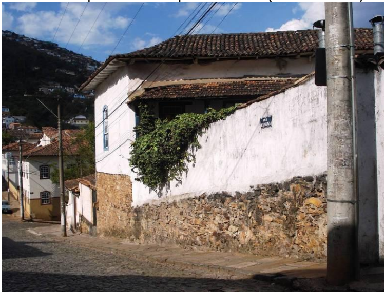
Vista da fachada para a Rua Dr. Alfredo Baeta (Fonte: SMPDU, 2009).
