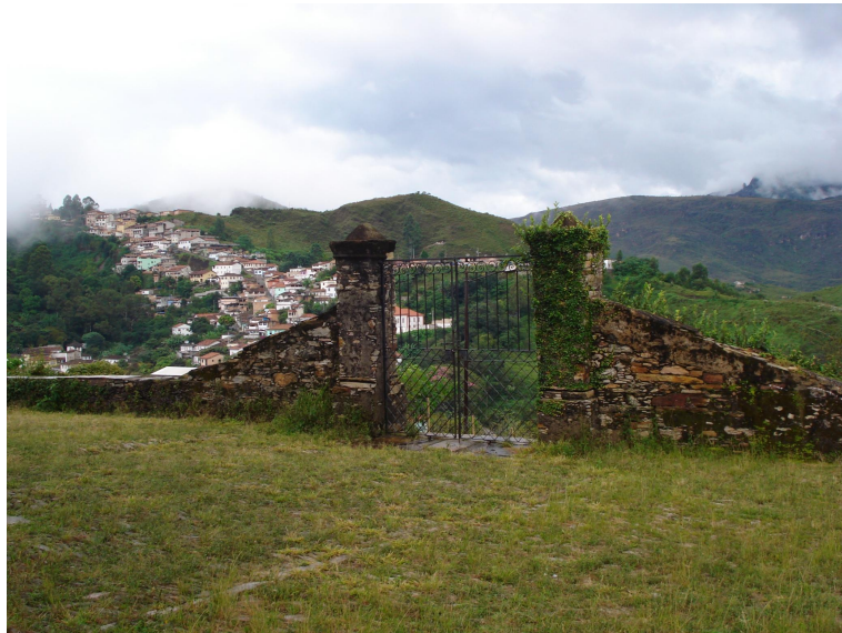
Portão de ferro e muro de pedra no adro da Igreja Fonte: Elen S. Ataíde. Arquivo digital SMPDU
