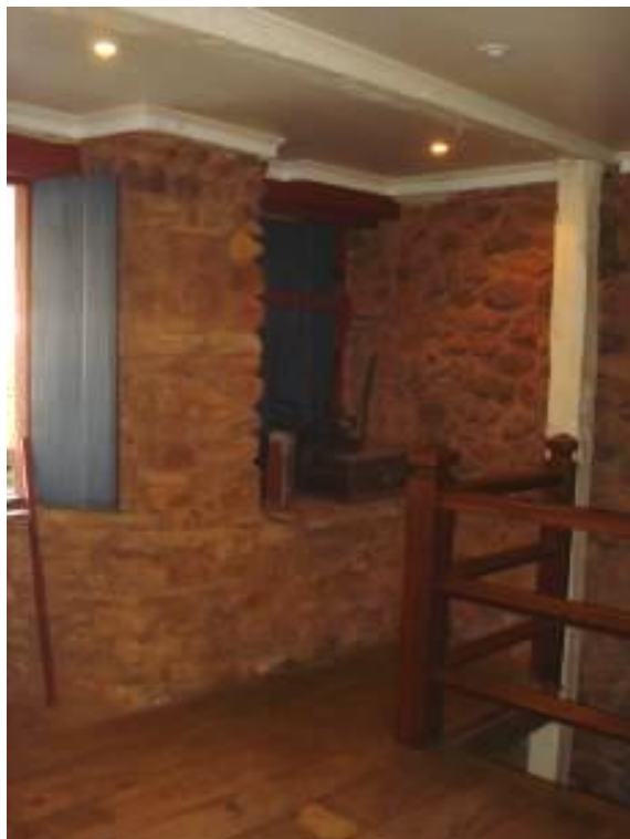
Detalhe da alvenaria de pedra dos compartimentos do fundo 2009 – Nilson Rodrigues
