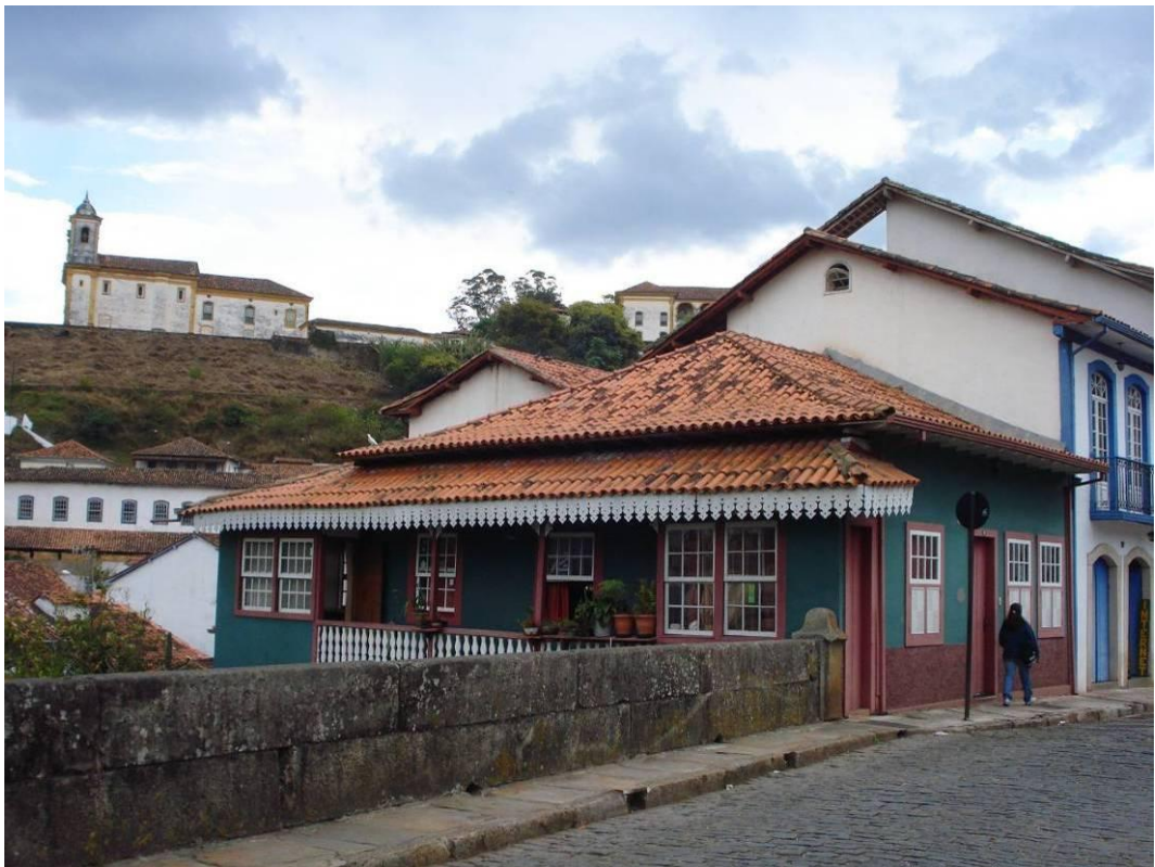
Vista da edificação e entorno 2009 – Nilson Rodrigues
