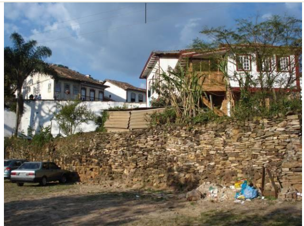
Vista do arrimo em pedra.
