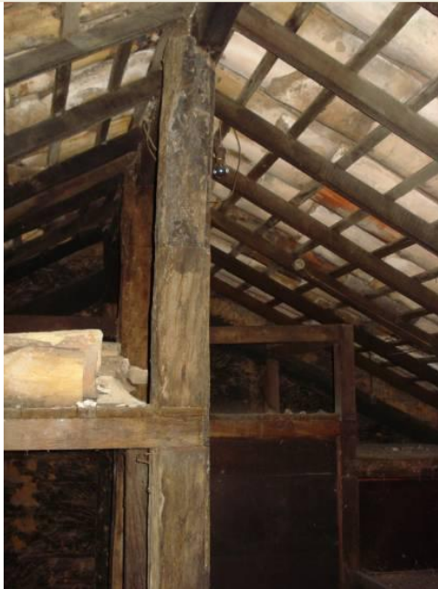
Sótão. Estruturas em madeira.
