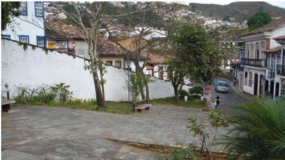
Vista do adro
