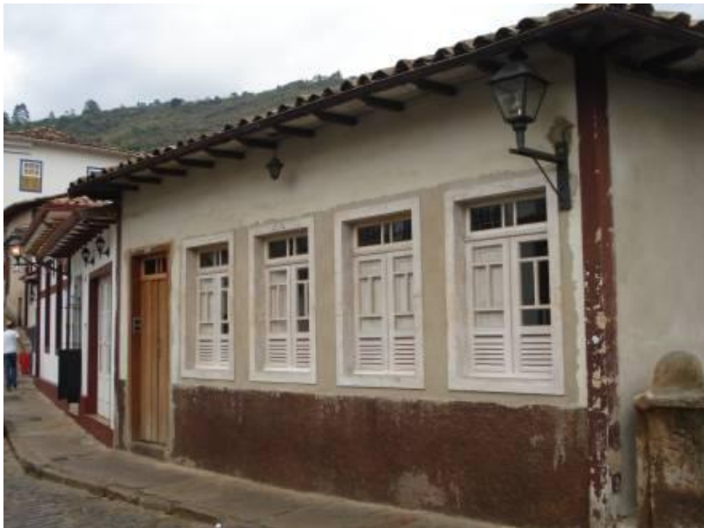
Vista da fachada frontal da edificação 2009 – Nilson Rodrigues
