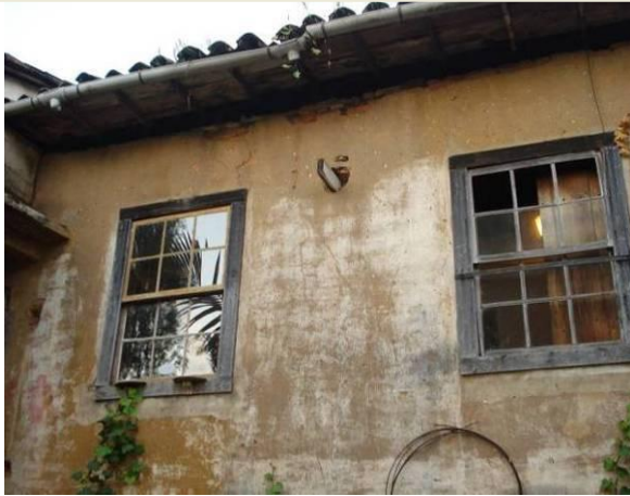
Vista da fachada dos fundos.
