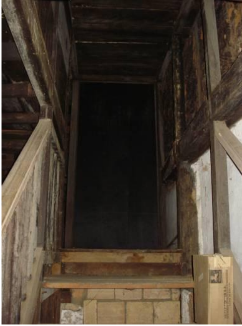
Escada de acesso ao sótão.
