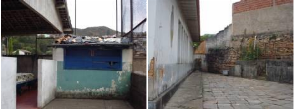
Detalhe da cantina e área lateral 2009 – Nilson Rodrigues
