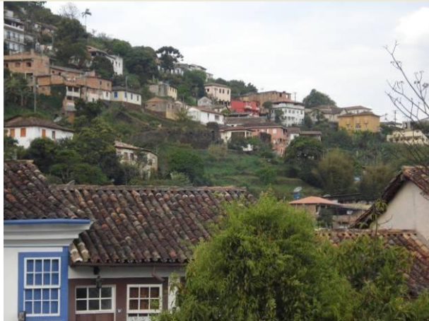
Vista da janela frente para a Rua da Conceição. Ocupações irregulares.
