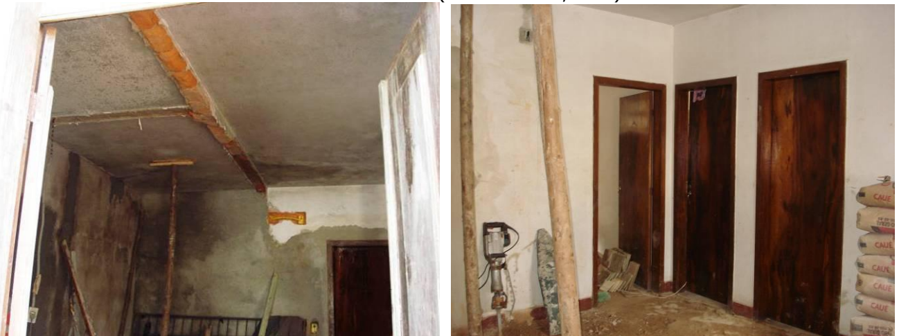
Vistas Internas atuais (Fonte: SMPDU, 2009)
