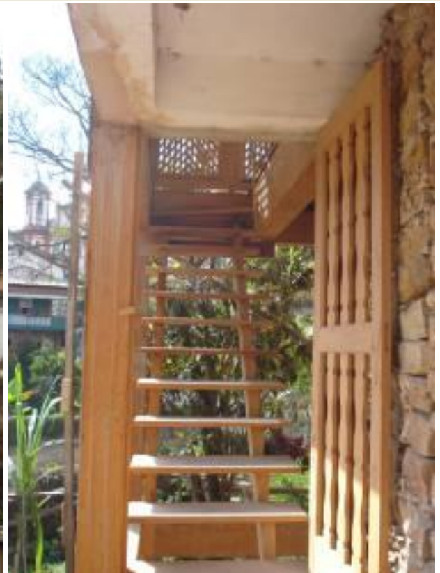
Vista do compartimento em reforma e detalhe da escada de madeira 2009 – Nilson Rodrigues
