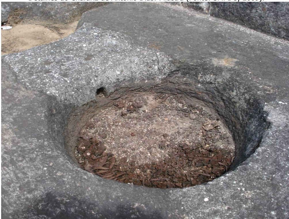
Detalhes do Chafariz de Antônio Dias: tanque inferior (Fonte: SMPDU, 2009).
