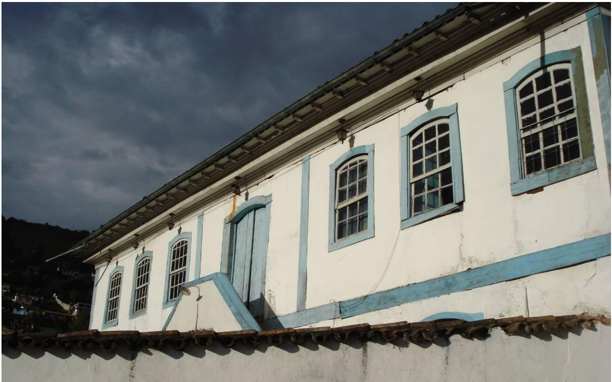
Fachada frontal, voltada para o Chafariz.
