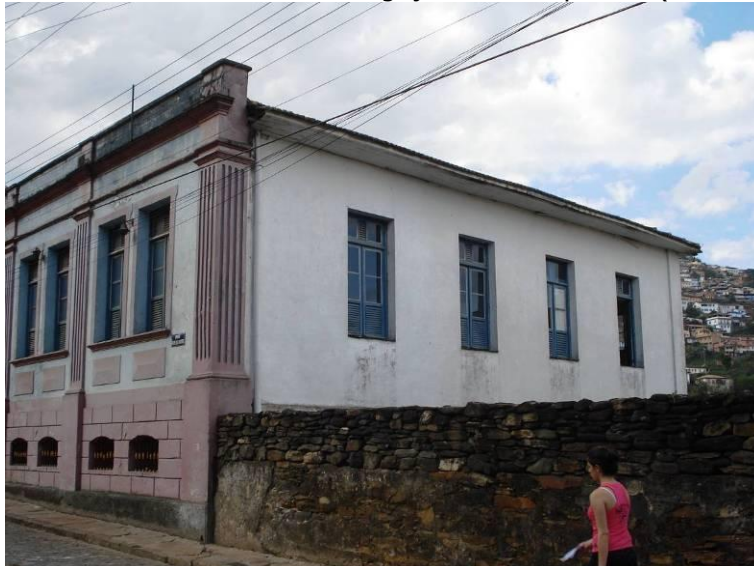
Detalhe do sistema construtivo da fachada – esquadrias e pilastras (Fonte: SMPDU, 2009).
