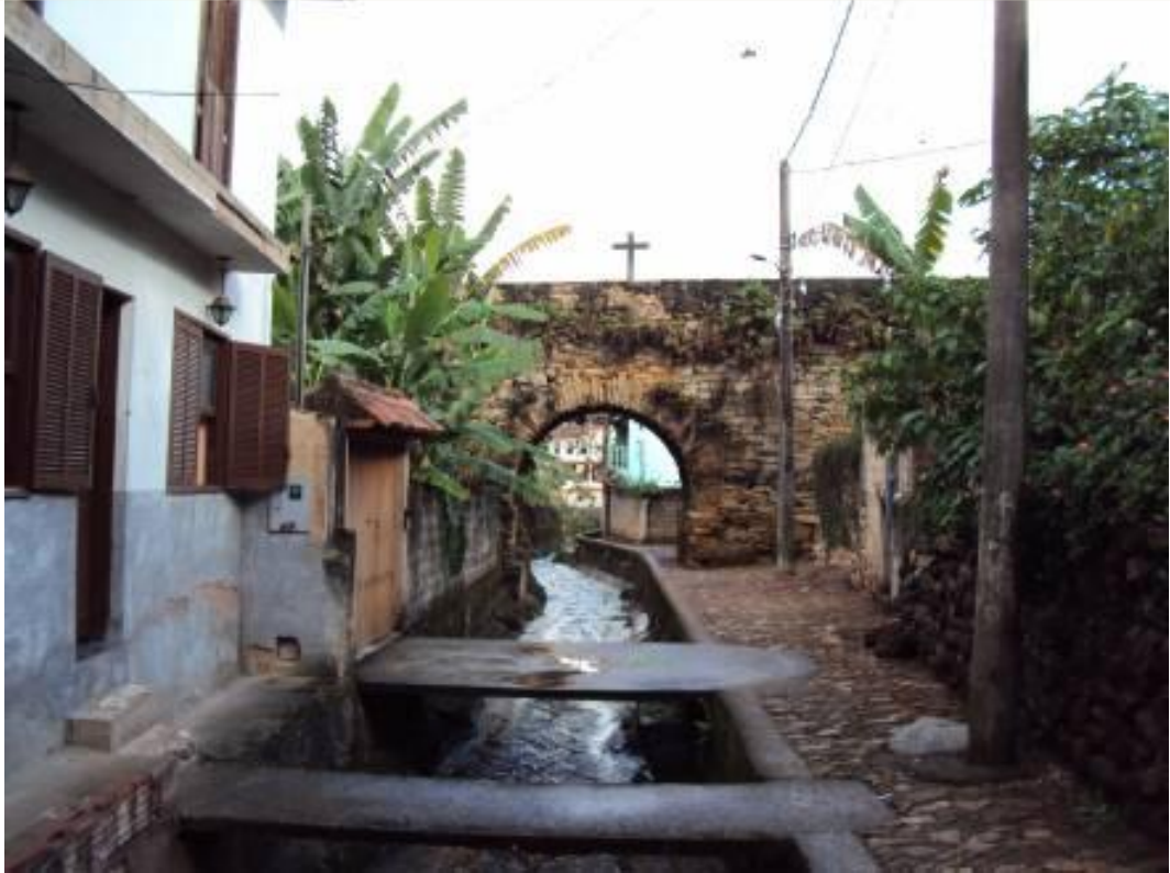
Vista da ponte – Lado oposto ao lado do cruzeiro 2009 – Nilson Rodrigues
