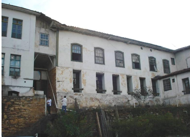
Vista da fachada posterior do imóvel (Fonte: SMPDU, 2009).
