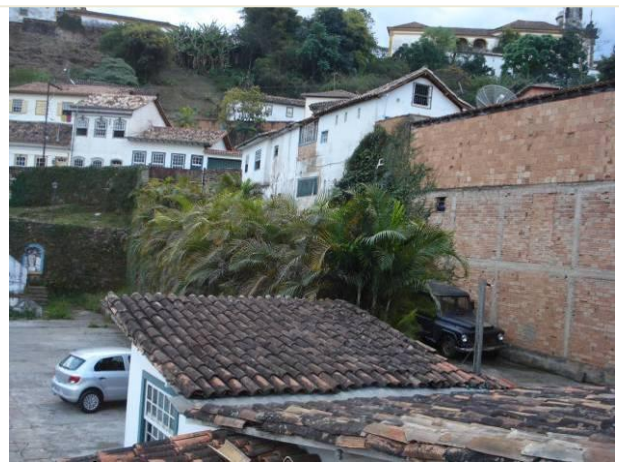
Área externa. Construções irregulares.
