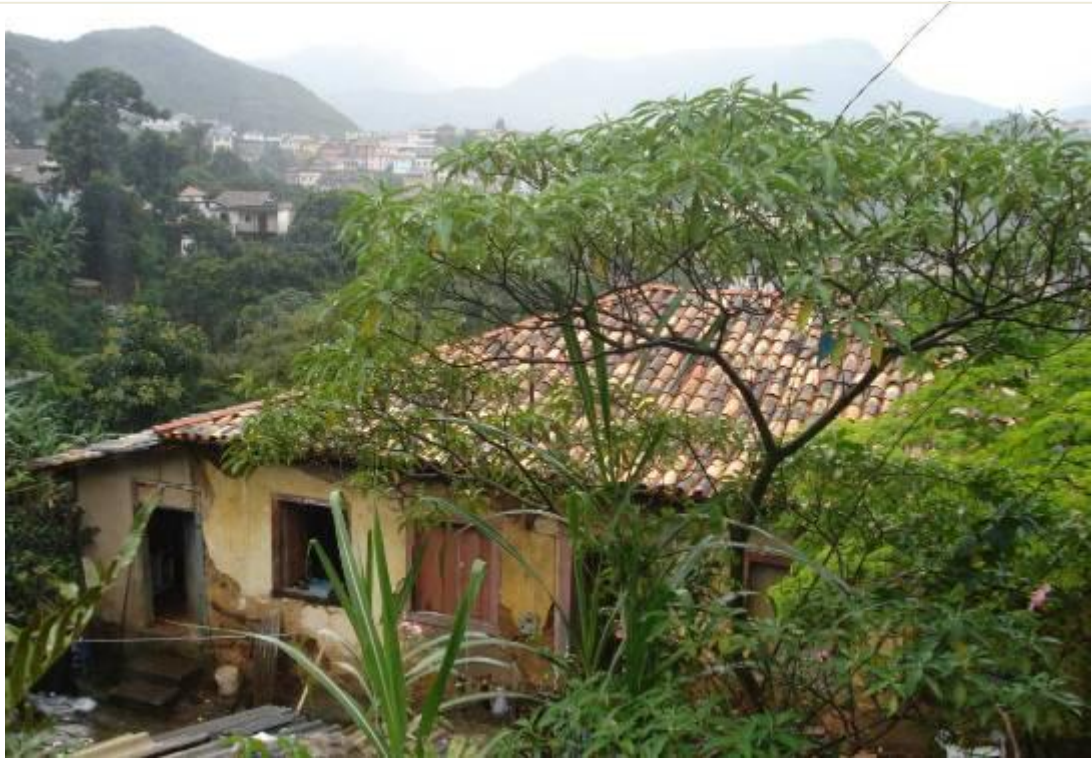
Vista do imóvel 2009 – Bruno Tropia Caldas
