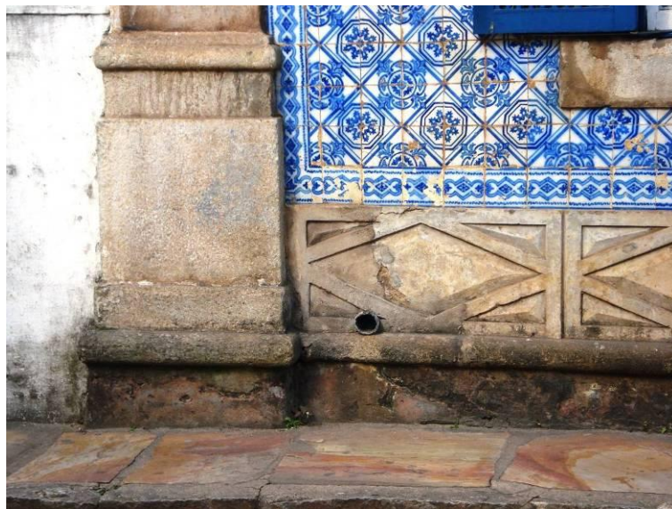
Detalhe do sistema construtivo da fachada – cantaria (Fonte: SMPDU, 2009).
