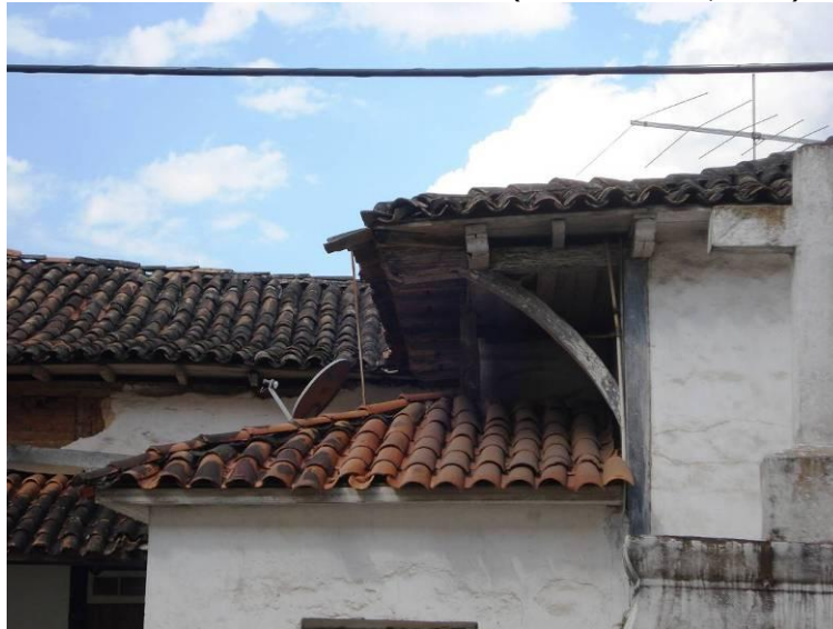
Vista do interior do imóvel – detalhe da mão francesa (Fonte: SMPDU, 2009).
