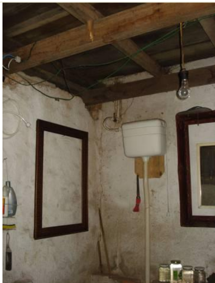
Aspecto do interior.
