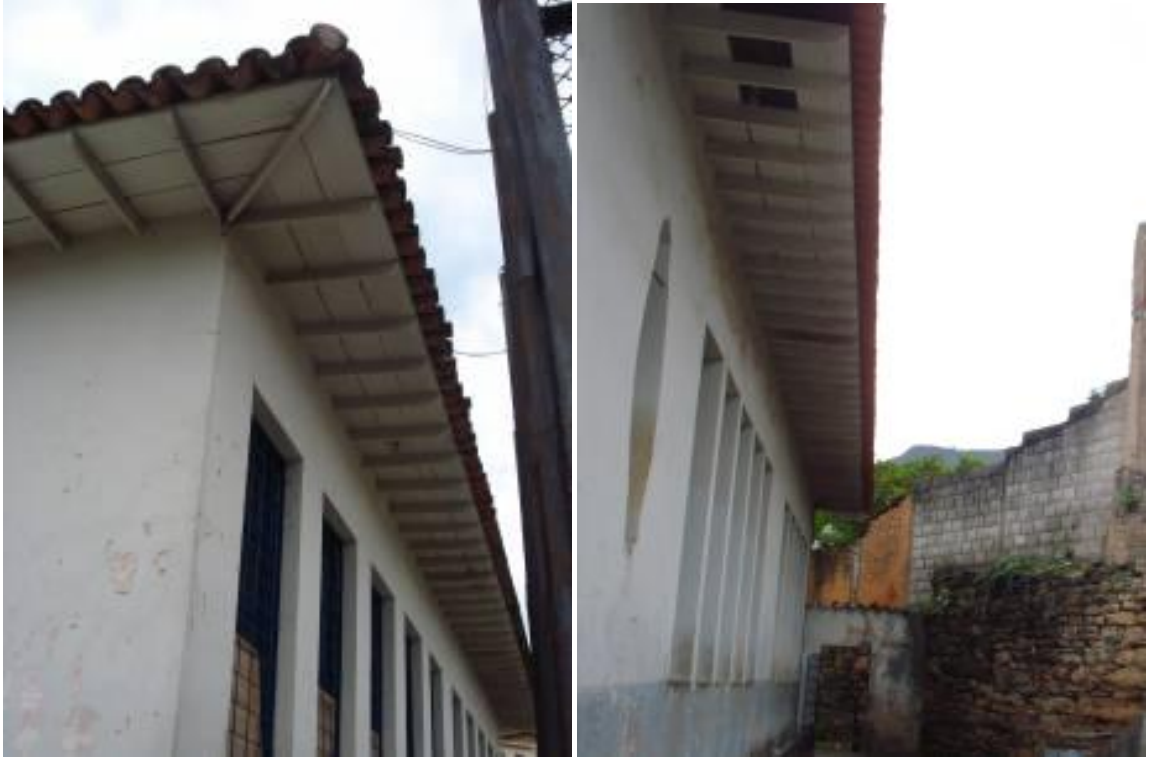
Detalhe dos beirais 2009 – Nilson Rodrigues
