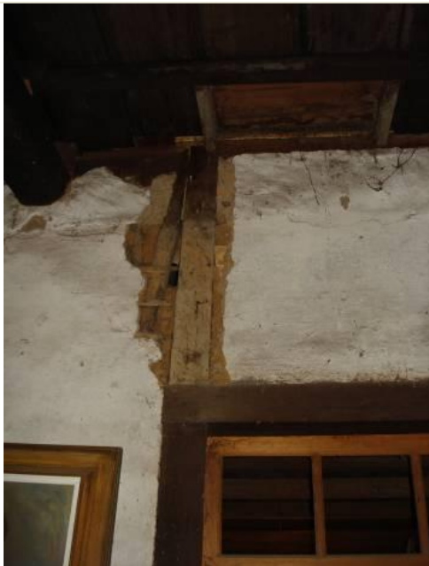
Detalhe do esteio aparente.
