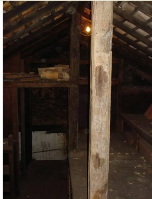
Aspecto do sótão.
