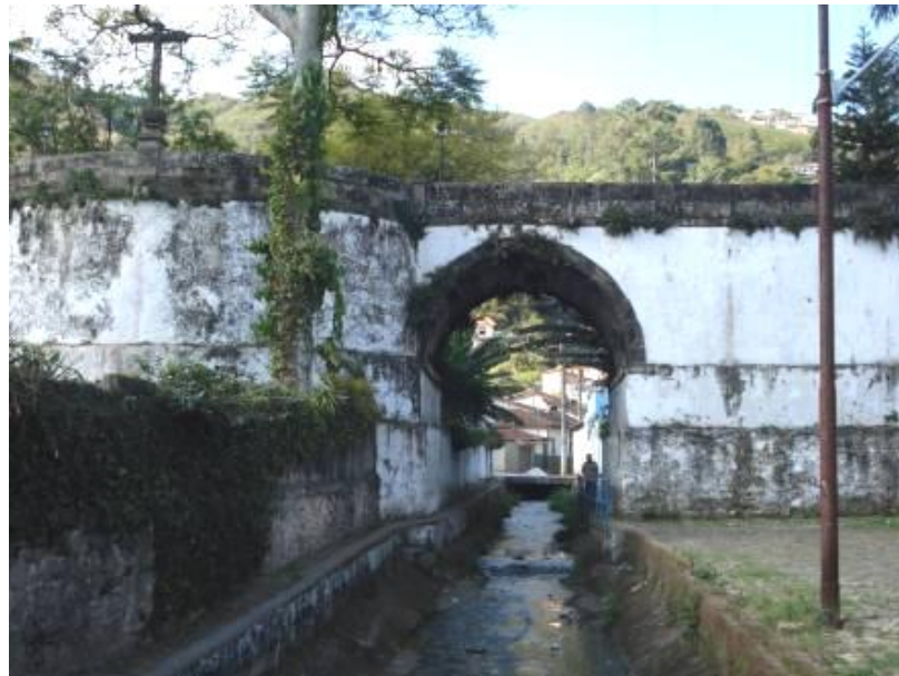
Vista da ponte – Lado do Cruzeiro 2009 – Nilson Rodrigues
