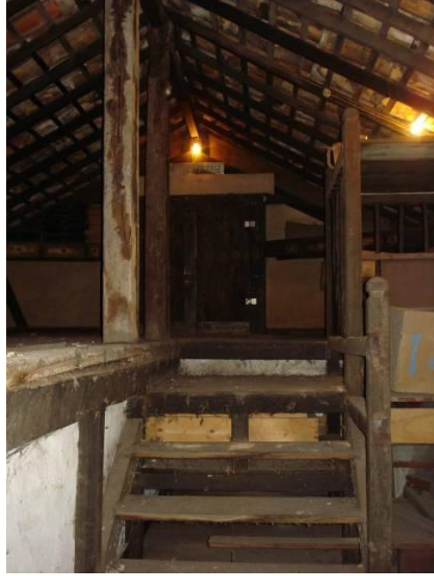
Sótão. Estruturas em madeira.
