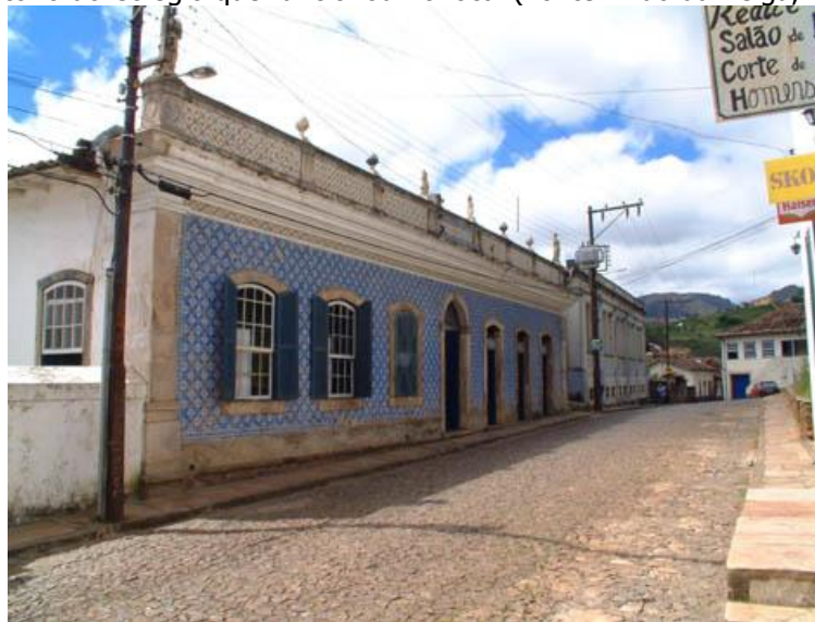
Vista exterior – Foto de 2002 (Fonte: IPHAN, 2002).
