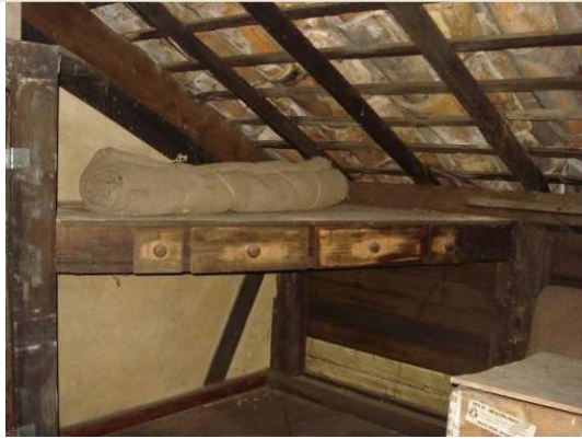
Aspecto do sótão. Detalhe de mesa na estrutura de madeira. Canto direito.
