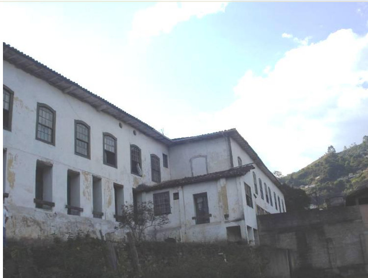
Vista da fachada posterior do imóvel (Fonte: SMPDU, 2009).
