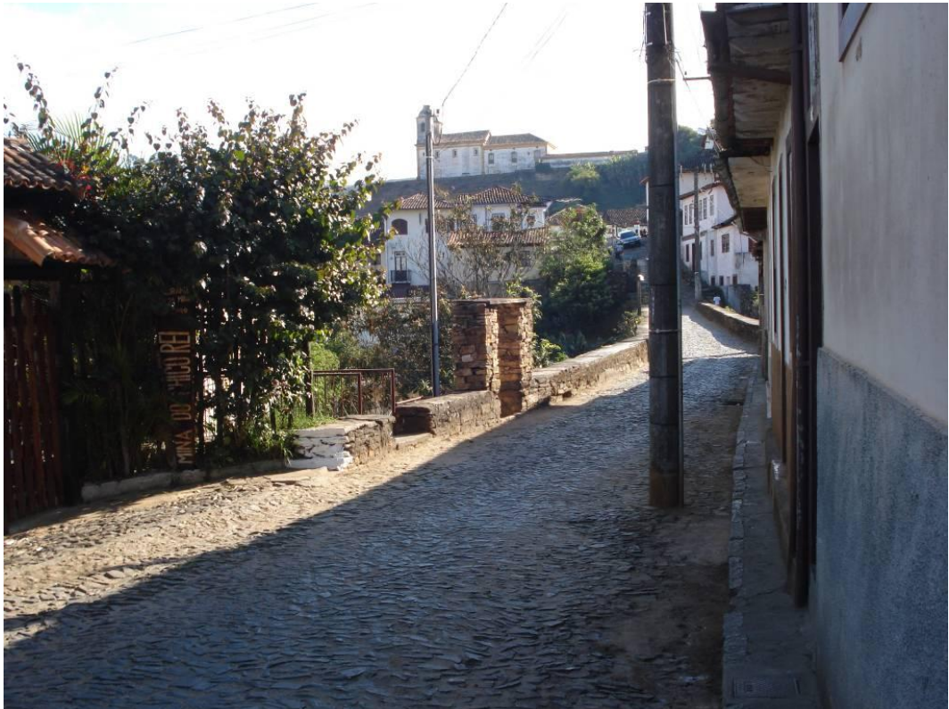
Vista do tabuleiro da ponte 2009 – Nilson Rodrigues
