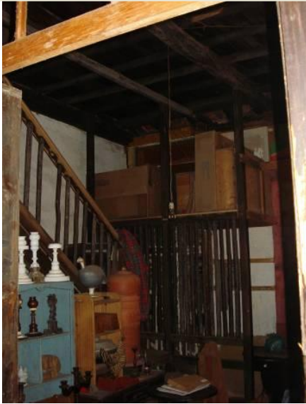
Estruturas em madeira.
