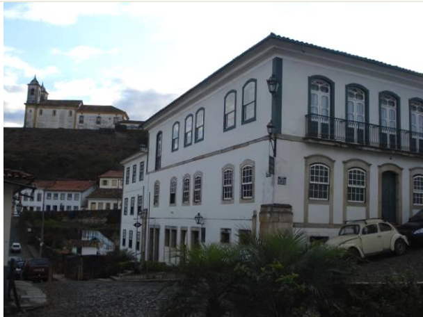
Vista do hotel, com a igreja Nossa Senhora das Mercês ao fundo.
