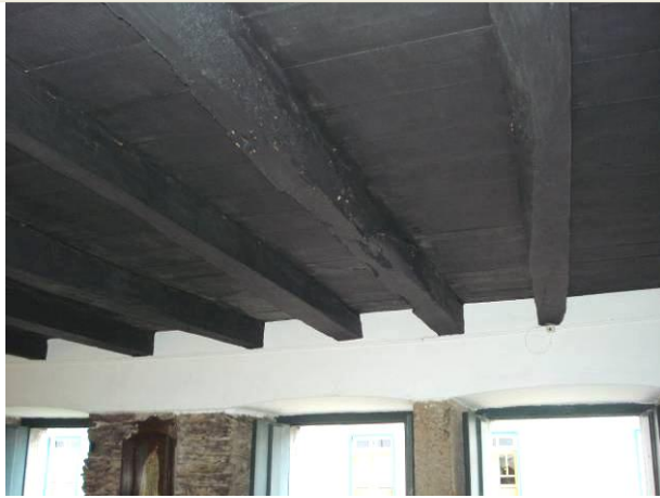
Detalhe do teto na entrada do hotel. Barrotes sob laje.
