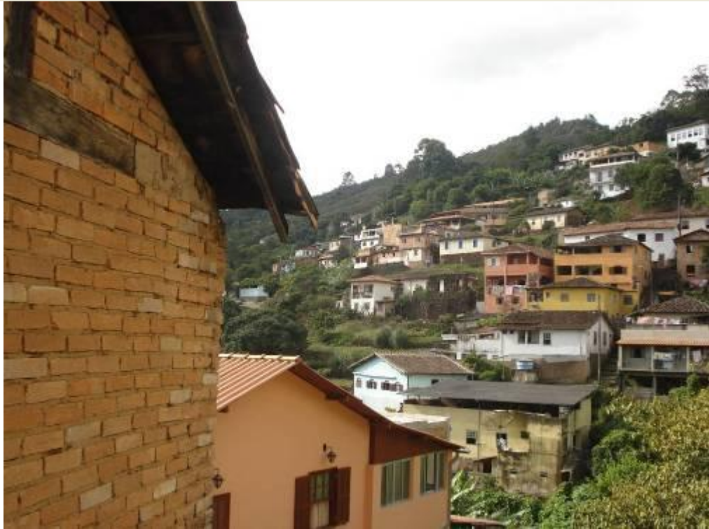
Vista parcial das Ruínas do Palácio Velho, a partir da Rua Dr. João Veloso. Destaque para a inserção de edificação junto ao entorno dominante com tipologias do século XX.
