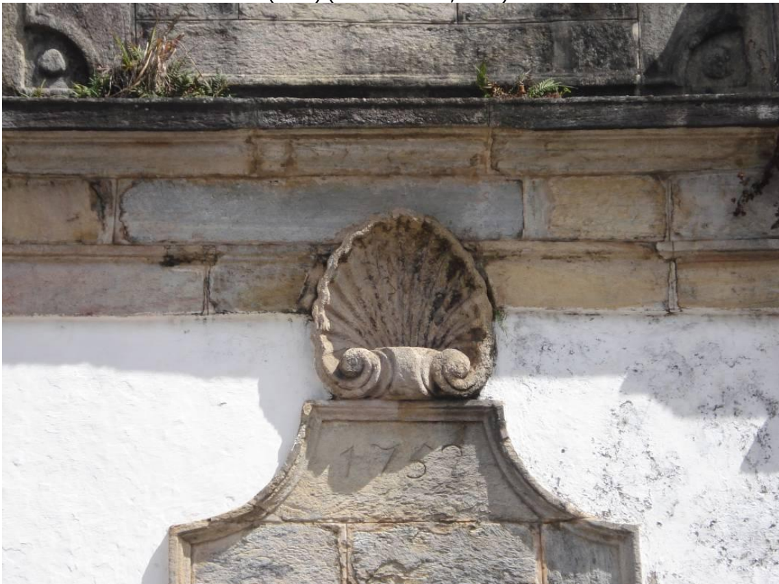
Detalhes do Chafariz de Antônio Dias: painel central encimado pela concha barroca e com a data gravada (1752) (Fonte: SMPDU, 2009).
