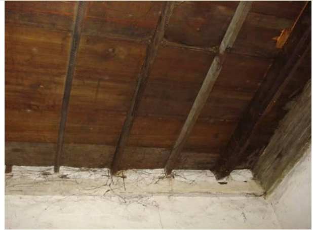
Acabamento do forro em madeira.
