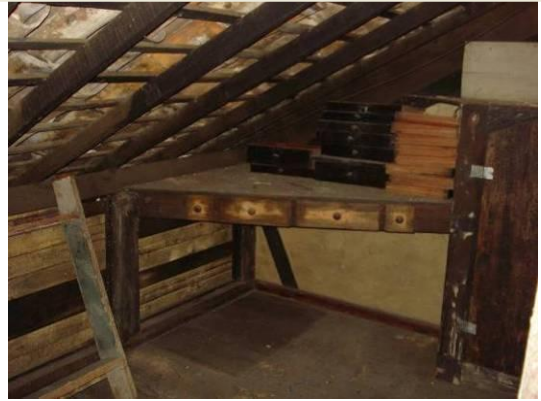
Aspecto do sótão. Detalhe de mesa na estrutura de madeira. Canto esquerdo.
