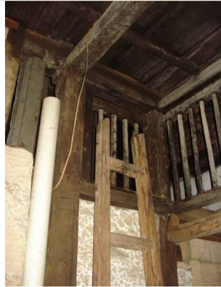
Estruturas em madeiras.
