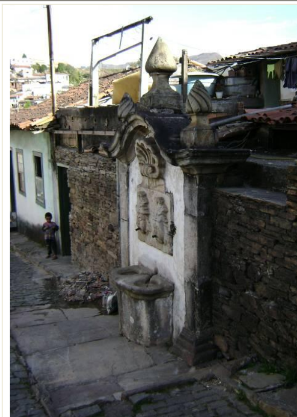
Ocupação irregular comprometendo a integridade do chafariz
