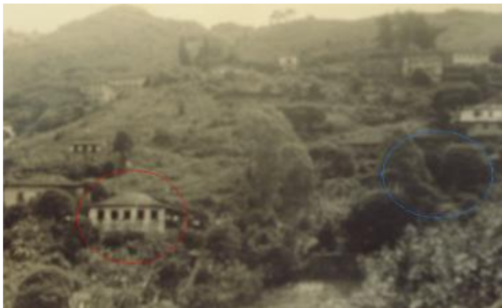
Foto de autoria de Sylvio de Vasconcelos, década de 1950. Destaque para a casa de Henrique Lopes de Araújo, vista pelos fundos, frisada em vermelho , e para o espaço onde se situam as ruínas do Palácio Velho, frisado em azul . (Fonte: IPHAN- 13ª Superintendência de Minas Gerais, Belo Horizonte, Arquivo do Centro de Documentação e Informação. Pasta Ouro Preto/Palácio Velho/ Henrique Lopes).
