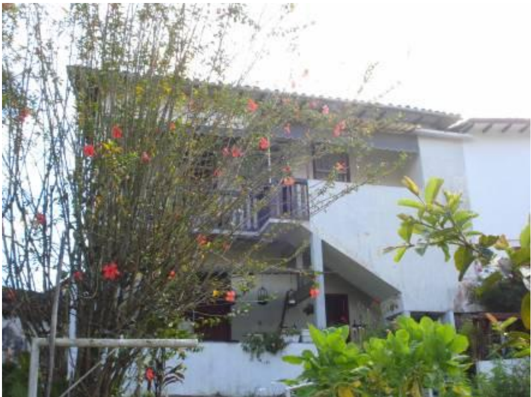
Vista da fachada posterior da edificação 2009 – Nilson Rodrigues
