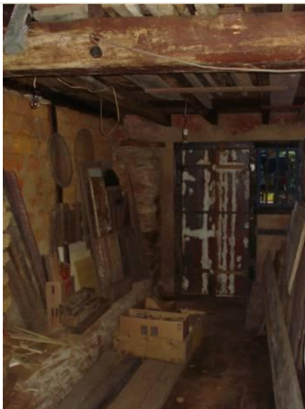
Porão. Estruturas em madeira.
