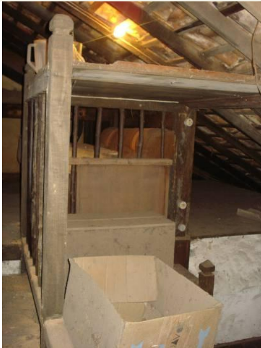
Aspecto do sótão.
