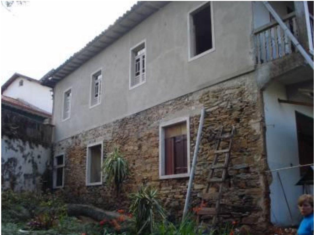
Vista da fachada lateral da edificação 2009 – Nilson Rodrigues
