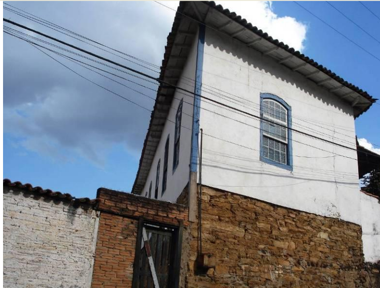
Vista da fachada para a Rua Dr. Alfredo Baeta (Fonte: SMPDU, 2009).
