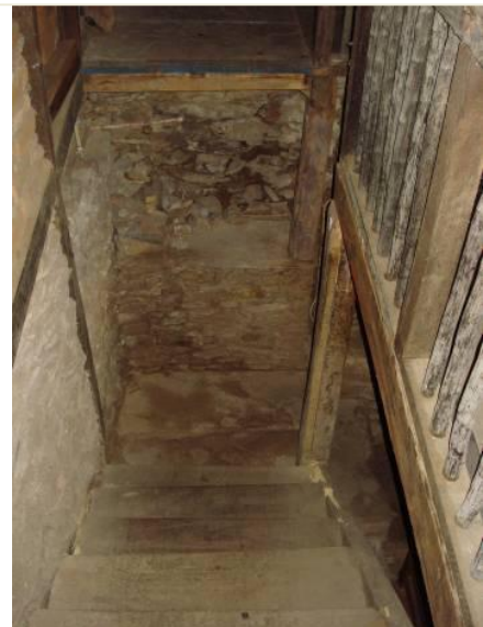
Escada de acesso ao porão.
