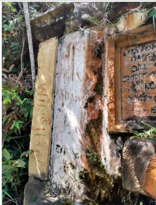
Foto 07: Alvenaria de pedra argamassada fortemente deteriorada e vandalizada;
