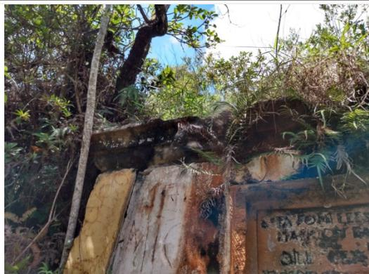
Foto 03: Parede central do Chafariz onde se vê a alvenaria de pedra argamassada fortemente deteriorada;
