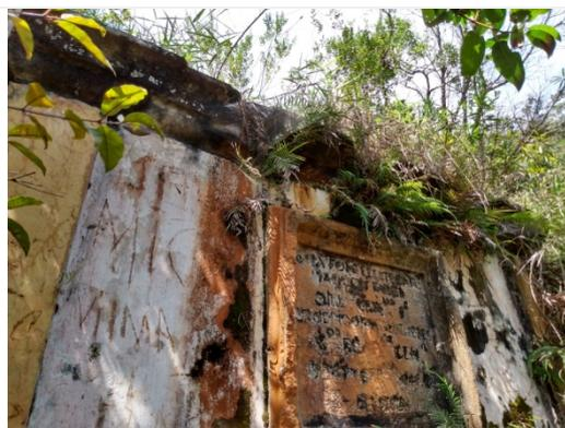
Foto 10: Revestimentos afetados e danificados pelas intempéries e por ações de vandalismo;
