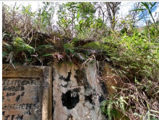
Foto 04: Parede central do Chafariz e parte do quadro (medalhão) onde se vê a alvenaria de pedra argamassada fortemente deteriorada e vasto crescimento de microflora;
