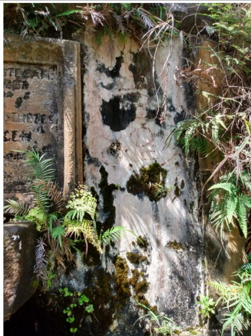
Foto 08: Alvenaria de pedra argamassada fortemente deteriorada e vasto crescimento de microflora;
