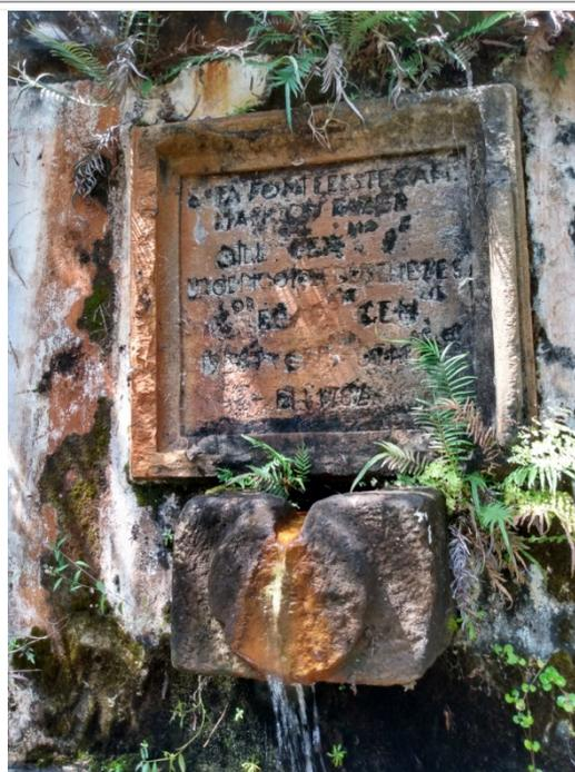
Foto 06: Vista da bica de pedra para saída de água com destaque para o acometimento da cantaria por microflora;
