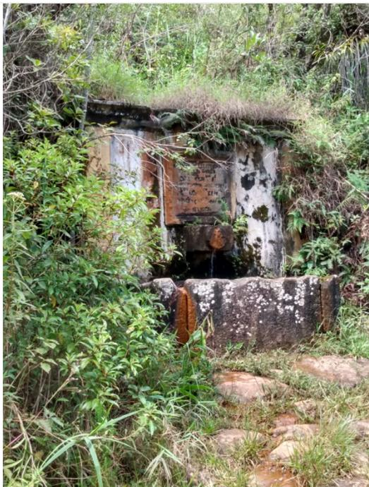
Foto 16: Destaque para manchas de oxidação nas áreas por onde a água escoa;
