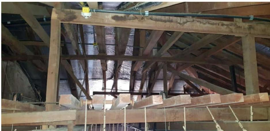
*Vista do madeiramento do telhado do Teatro Municipal – O madeiramento e o telhamento deverão ser revistos para identificação de itens a serem substituídos; o forramento e o madeiramento deverão receber limpeza por aspiração e imunização com cupinícida.*
