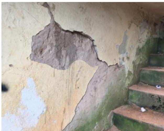
**Foto 14: Pontos de remoção de reboco**
