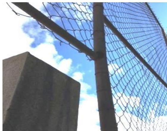
**Foto 04: Parte do alambrado danificado**
