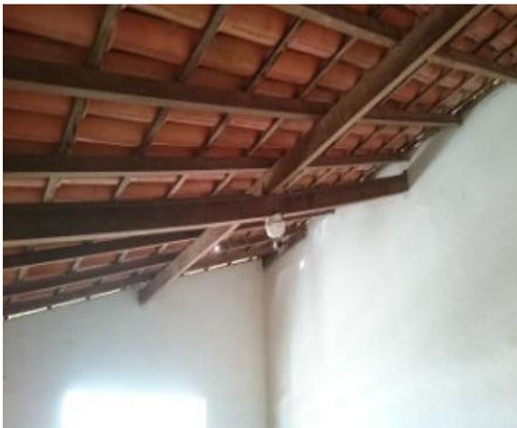
**Foto 19: Telhado sem forro**
