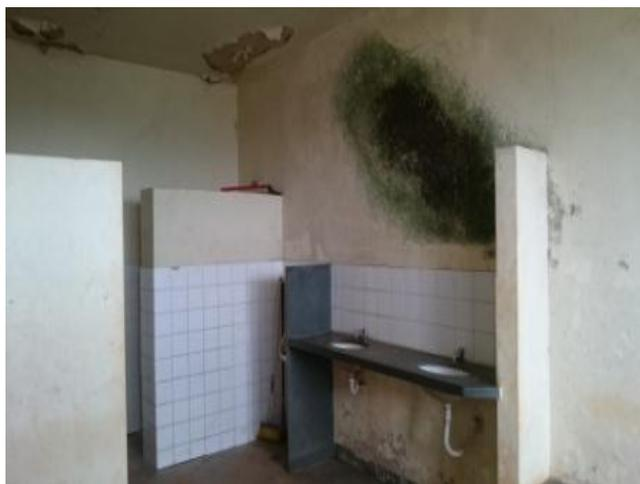
**Foto 12: Pontos de infiltração**
