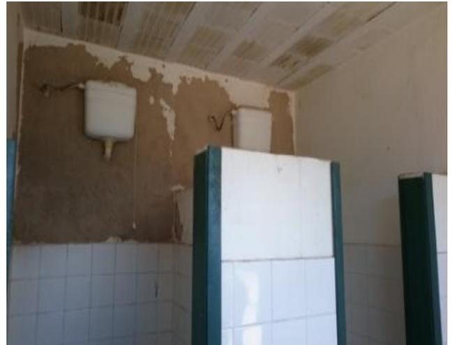
**Foto 24: Pintura descascando**
