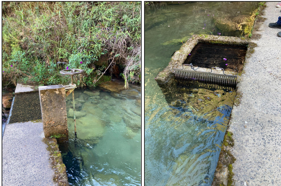
Figura 1. Ponto de captação
