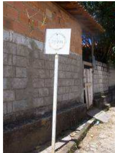
Foto 11.7 – Sinalização de trânsito na Rua da Praia com pintura desgastada
