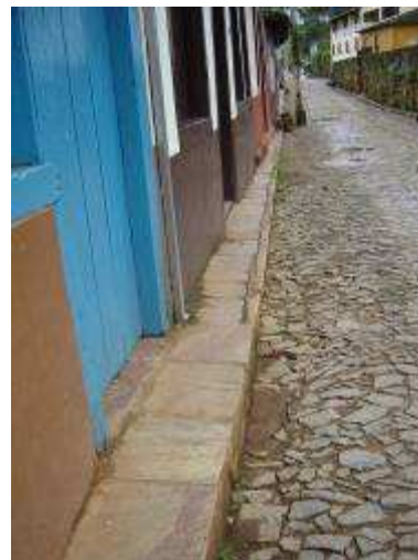
Foto 11.13 – Detalhe de passeio revestido com lajes de pedra na Rua do Carmo, afunilando
