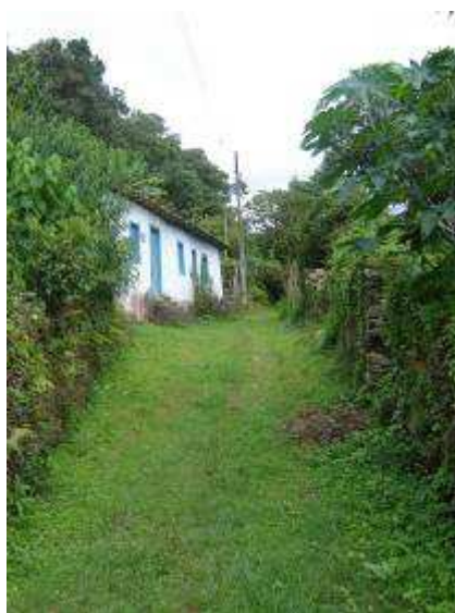
Foto 11.3 – Calçamento do Beco dos Bois
