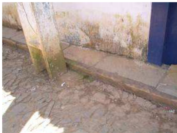
Foto 11.11 – Detalhe de calçada na Rua do Carmo revestida com lajes de pedra
