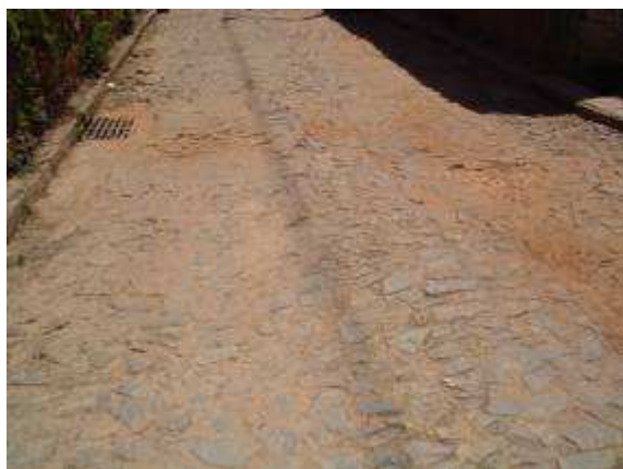
Foto 11.1 – Exemplo de calçamento na Rua do Carmo.
