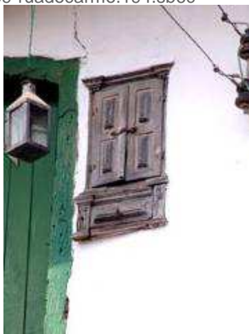
Vista detalhe – oratório – fachada principal
