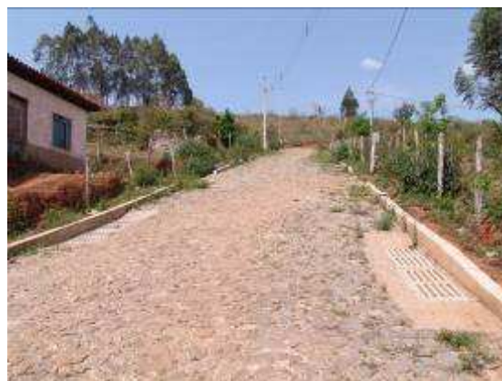
Rua Estrada da Fazenda, vista de baixo da rua lateral
