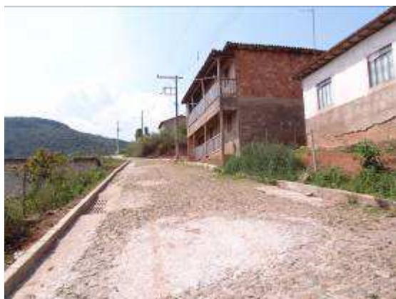
Rua Estrada da Fazenda, vista da parte baixa
