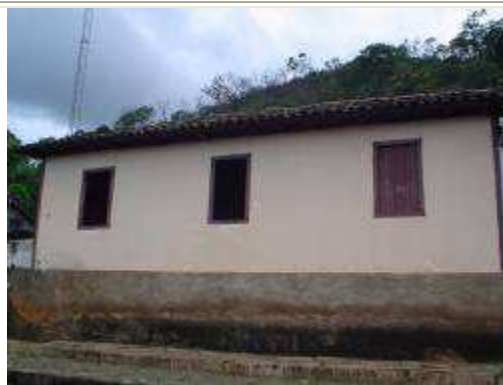
Fachada frontal da edificação
