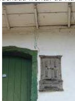
Detalhe do oratório integrado à alvenaria da fachada frontal
