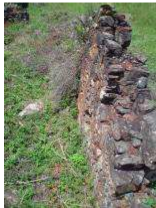
Parte da parede de pedras assentadas com argamassa de barro e detalhe da parede
