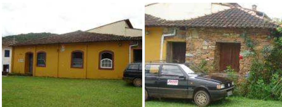
Fachada frontal do Adro da matriz e anexo
