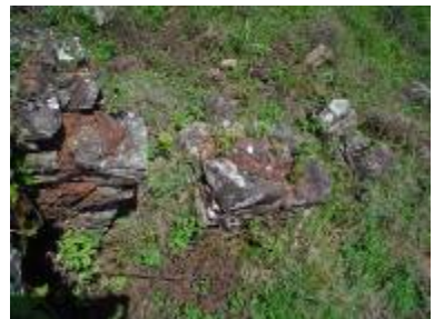
Parte da parede de pedras assentadas com argamassa de barro e detalhe da parede
