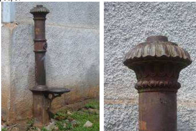
Vista lateral e detalhes do hidrante de ferro
