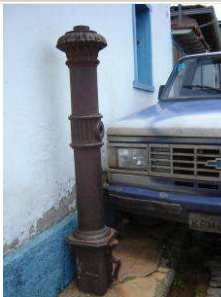
Vista Lateral do hidrante de ferro da Rua Espírito Santo
