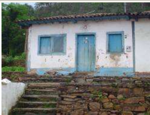
Fachada frontal da edificação
