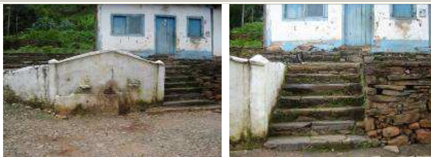
Vista frontal do chafariz e detalhe da escada lateral
