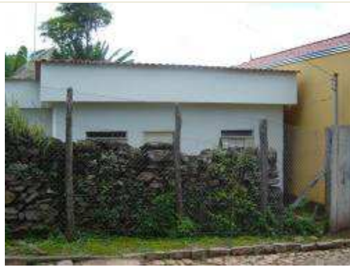
Fachada frontal da edificação
