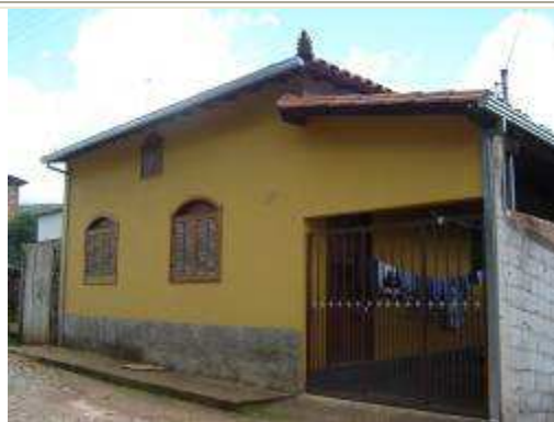
Fachada frontal da edificação
