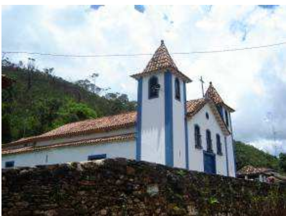
Foto 9.36 – Igreja Matriz de São Bartolomeu. Autor: Raquel A. Ferreira. São Bartolomeu, março de 2007.
