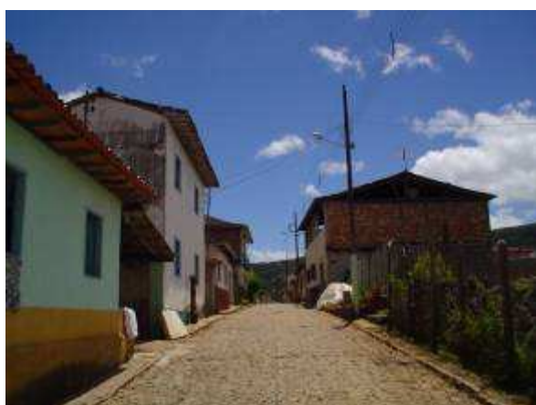
Foto 9.47 –Conjunto de casas da Rua do Carmo. Autor: Raquel A. Ferreira. São Bartolomeu, março de 2007.
