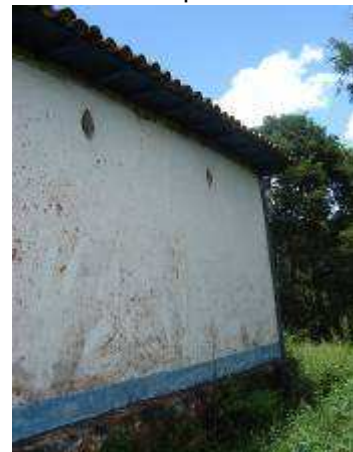
Detalhes da parede lateral com reboco e pintura desprendendo
