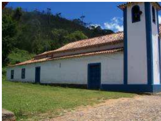
Foto 3.23 – Fachada lateral esquerda da Matriz de São Bartolomeu. Autor: Inaiana Barbosa Guerra Data: 02-03-2007
