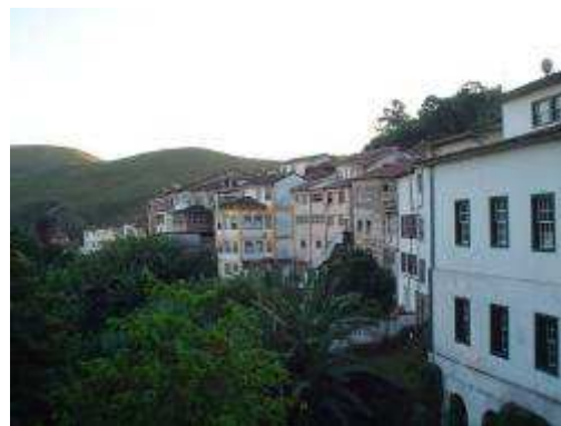
Foto 2.51- Anexos que descaracterizam os fundos das edificações da Rua São José Autoria: Raquel A. Ferreira Data: Março de 2007
