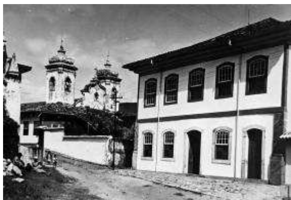
Foto 2.29- Torres da Igreja Matriz de N. Sra. do Pilar vista por trás do casario. Fonte: Acervo IFAC
