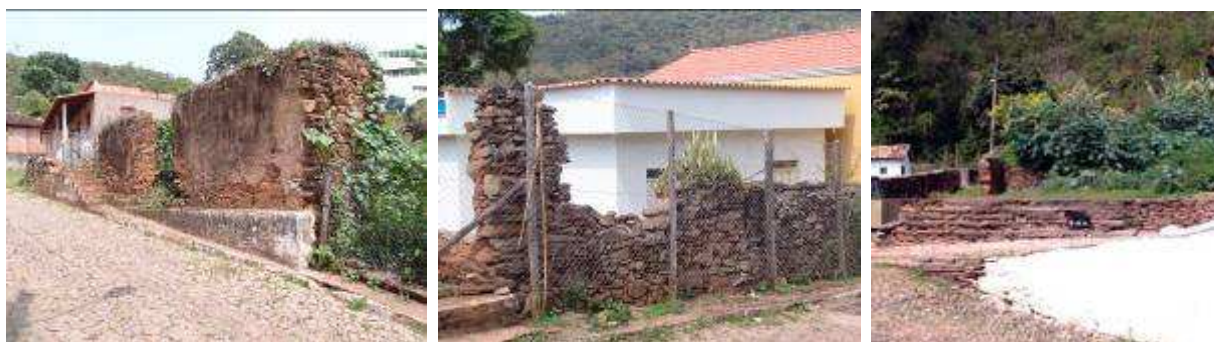
Foto 4.15, 4.16 e 4.17 – Uma ruína na Rua do Espírito Santo e duas ruínas na Rua do Carmo Autor: Bruno Tropia Caldas Janeiro de 2007
