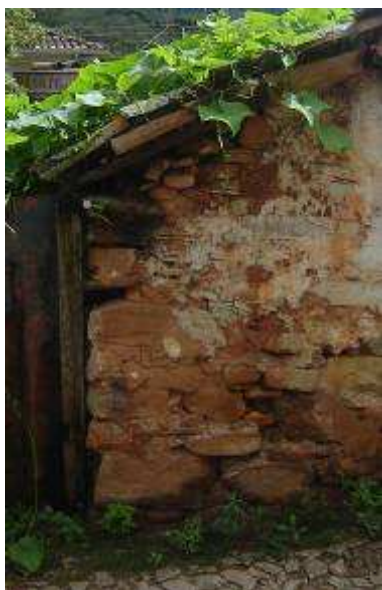
Fotos 4.10 e 4.11 – Exemplos de edificações com o sistema construtivo todo em pedra Autor: Raquel Alves Ferreira Janeiro de 2007
