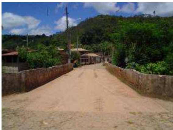
Foto 9.15 – Vista da ponte da Rua do Córrego Acima. Autor: Raquel A. Ferreira. São Bartolomeu, março de 2007.
