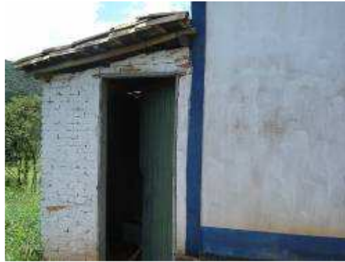
Anexo construído aos fundos da capela
