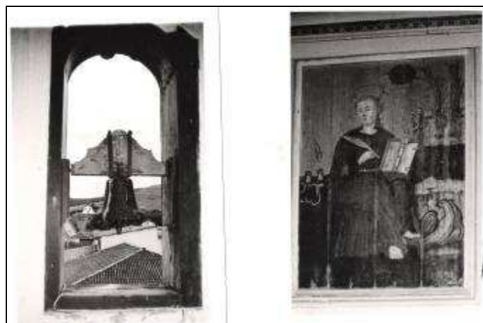
Foto 3.18 e 3.19- Sino de madeira da torre do lado do evangelho; pintura do painel parietal da capela-mor Fonte: Acervo Ge Fortes
