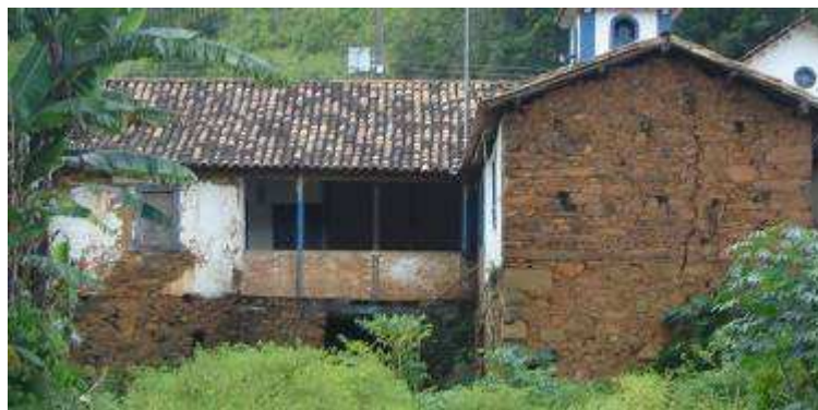
Fotos 4.10 e 4.11 – Exemplos de edificações com o sistema construtivo todo em pedra Autor: Raquel Alves Ferreira Janeiro de 2007
