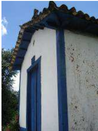
Detalhes da parede lateral com reboco e pintura desprendendo
