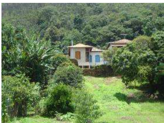
Foto 9.27 – Vista dos fundos dos lotes das casas da Rua do Carmo a partir da Rua da Praia. Autor: Bruno Tropia. São Bartolomeu, janeiro de 2007.
