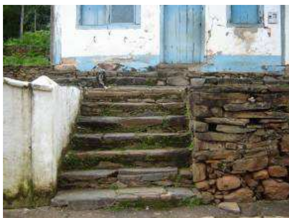
Foto 9.41 – Detalhe de escadaria de pedra. Autor: Raquel A. Ferreira São Bartolomeu, janeiro de 2007.
