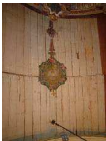
Foto 3.52 – Forro da capela-mor. Autor: Raquel A. Ferreira Data: 02-03-2007
