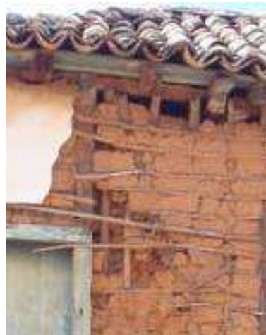
Fotos 4.8 e 4.9 – Exemplos de edificações com o sistema construtivo em estrutura de madeira e vedação em pau-a-pique Autor: Raquel Alves Ferreira Janeiro de 2007
