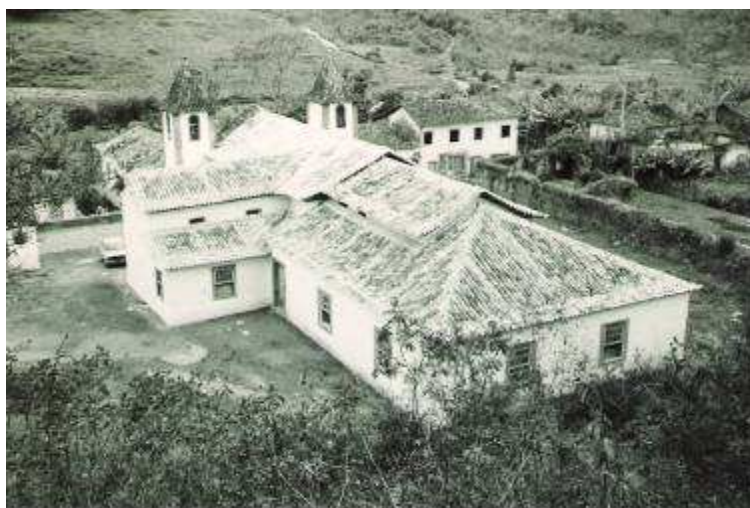
Foto 3.14- Vista do telhado da Matriz Fonte: Acervo IEPHA
