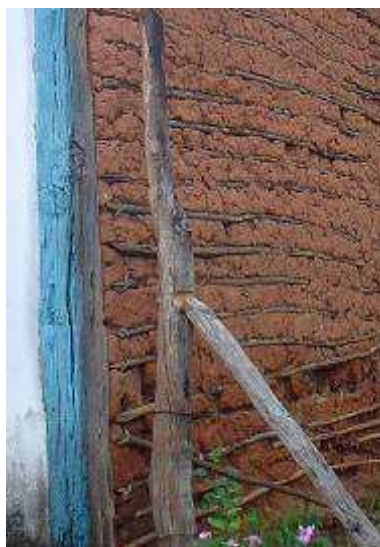
Fotos 4.8 e 4.9 – Exemplos de edificações com o sistema construtivo em estrutura de madeira e vedação em pau-a-pique Autor: Raquel Alves Ferreira Janeiro de 2007
